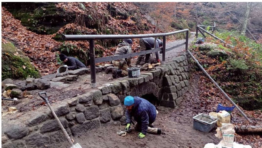
Oprava jednoho z mostků nad Olžiným pádem.
