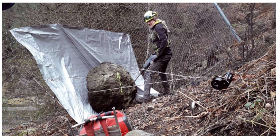
Výškový specialista pan Konupka při odstraňování kamene zachyceného vysokozátěžovou bariérou nad penzionem Klepáč. Foto: Tomáš Salov
