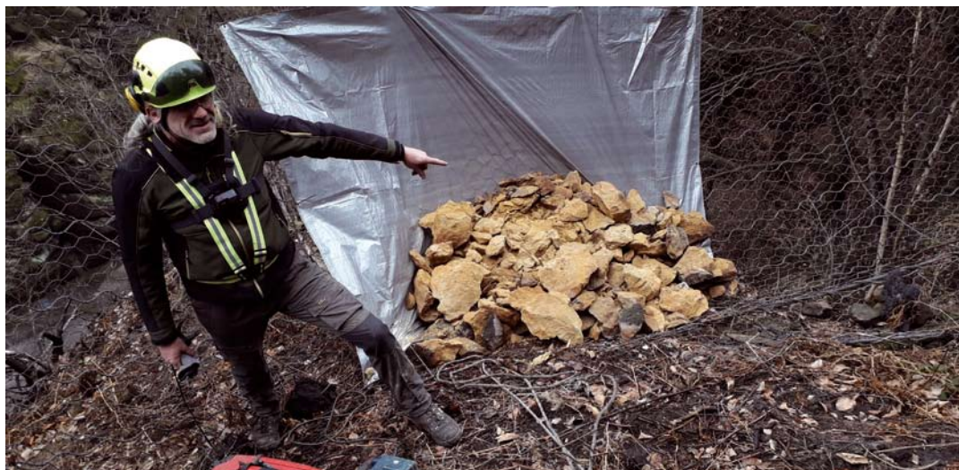
Výškový specialista pan Konupka při odstraňování kamene zachyceného vysokozátěžovou bariérou nad penzionem Klepáč. Foto: Tomáš Salov
