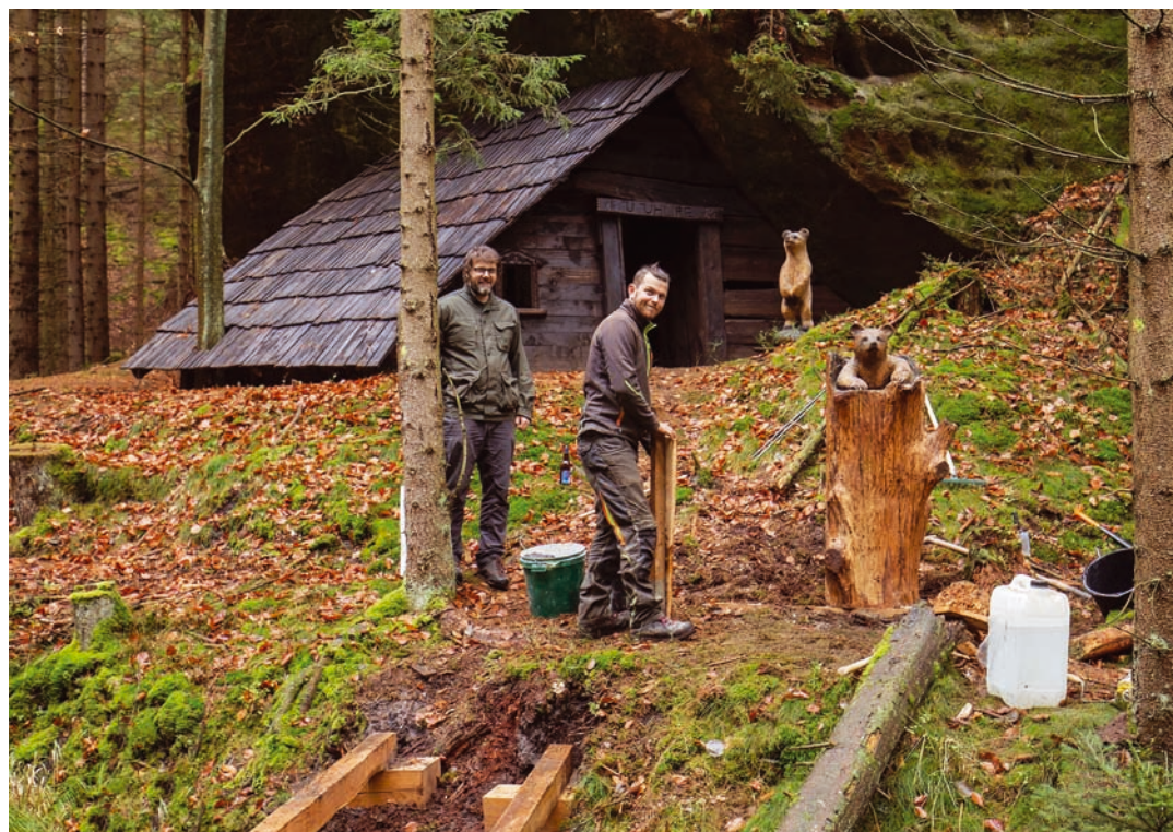
Montáž dřevěných soch medvědů před zrekonstruovanou uhlířovou chaloupkou z Pyšné princezny.
