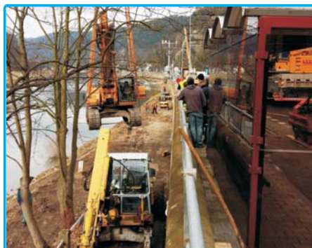
práce na nábřeží - str. 5
