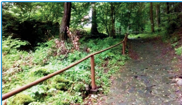
oprava zábradlí - str. 3
